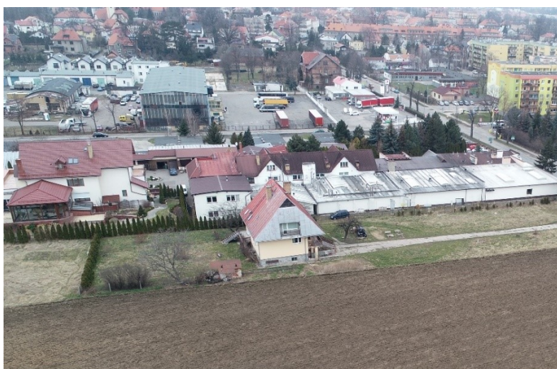
Rysunek 7 Budynek mieszkalny jednorodzinny znajdujący się na terenie opracowania w części A (źródło: Michał Mandziuk)
